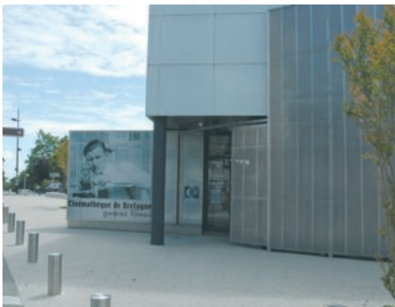
Juin 2008, un nouveau visage pour la Cinémathèque de Bretagne après une dizaine de mois de travaux sur le square Beethoven.
